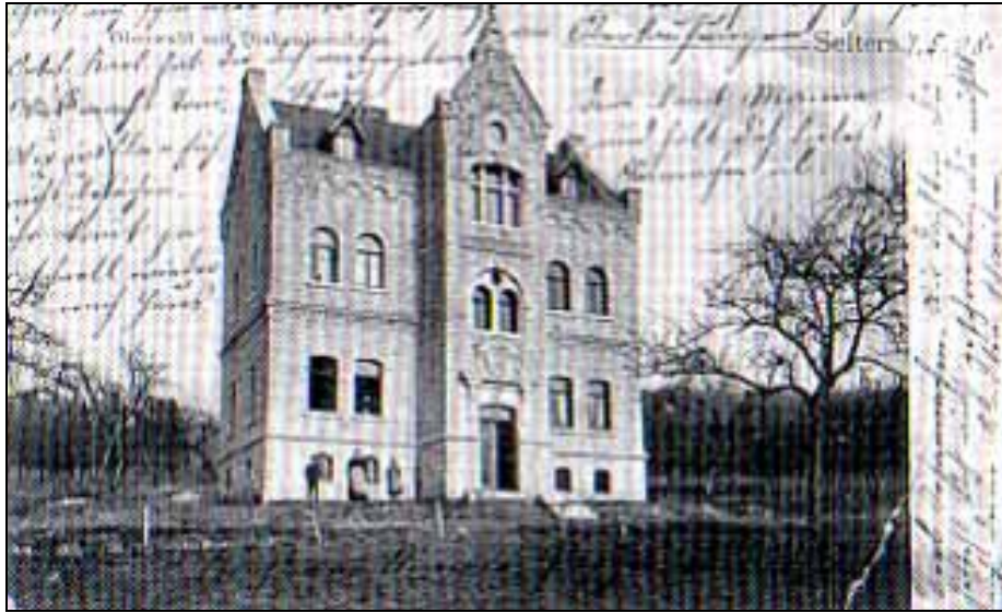
Der Erstbau des Selterser Krankenhauses im Jahre 1903
